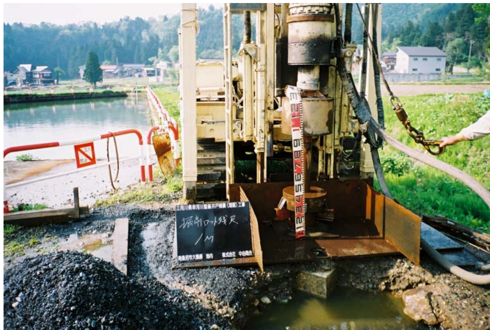
掘削完了後の残尺測定
