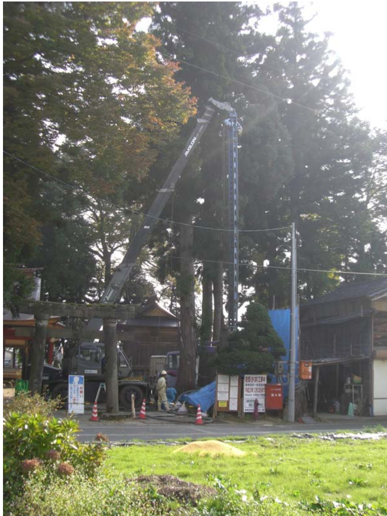
1 2 t クレーンを使用した掘削作業状況 神社境内にて（南魚沼市発注）
