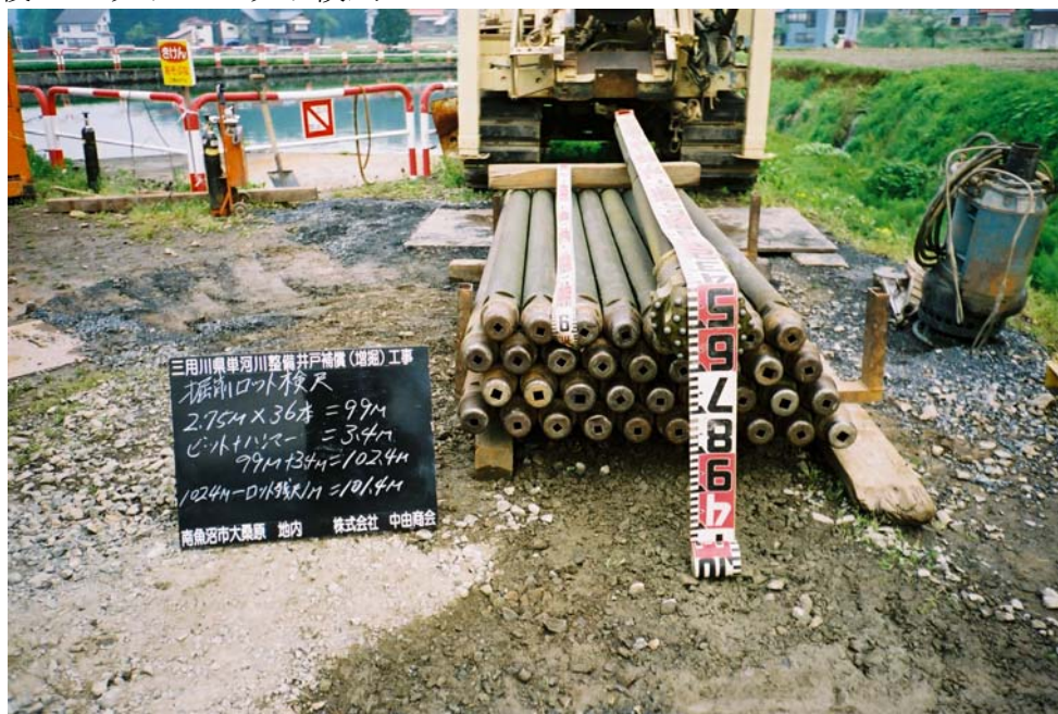
掘削完了後のロッド・ビット検尺
