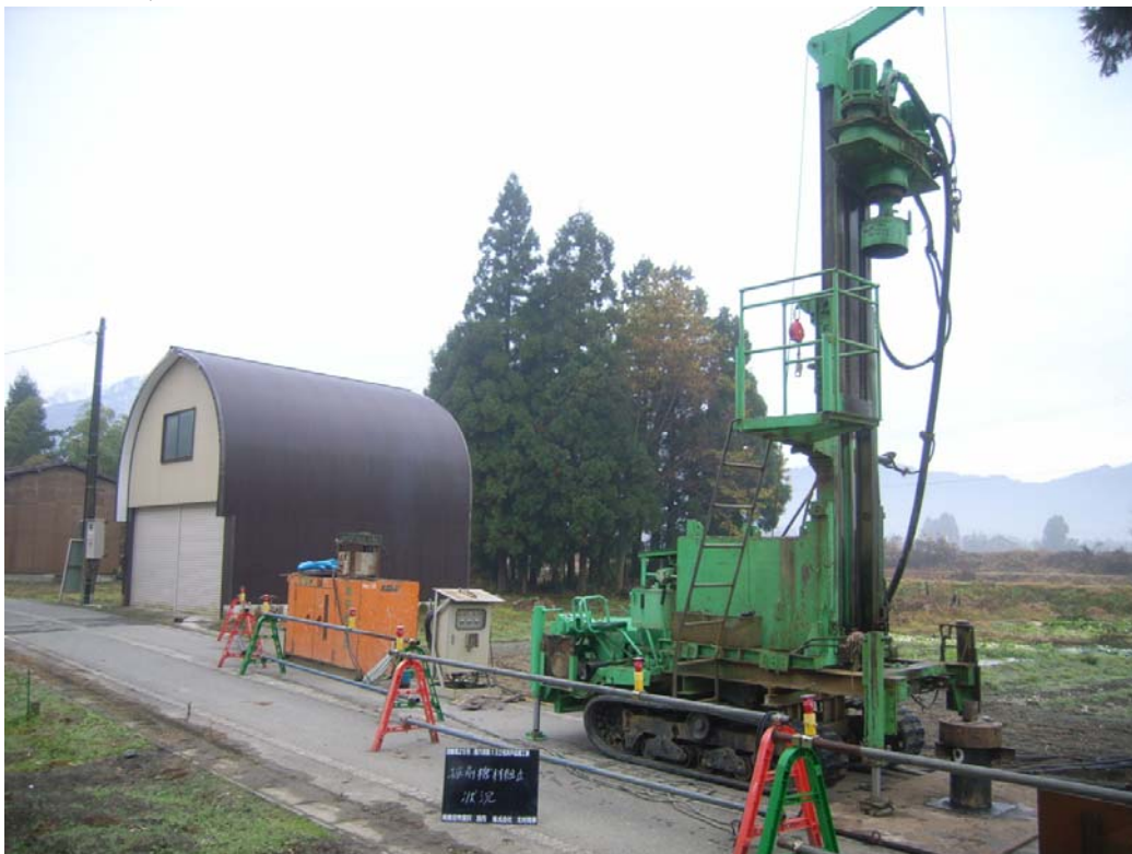
小型機による増掘工事 全景（南魚沼市発注）
