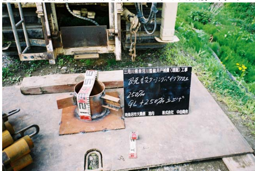
仮設工 既設管立上・鉄板養生（ピット内保護・養生）
