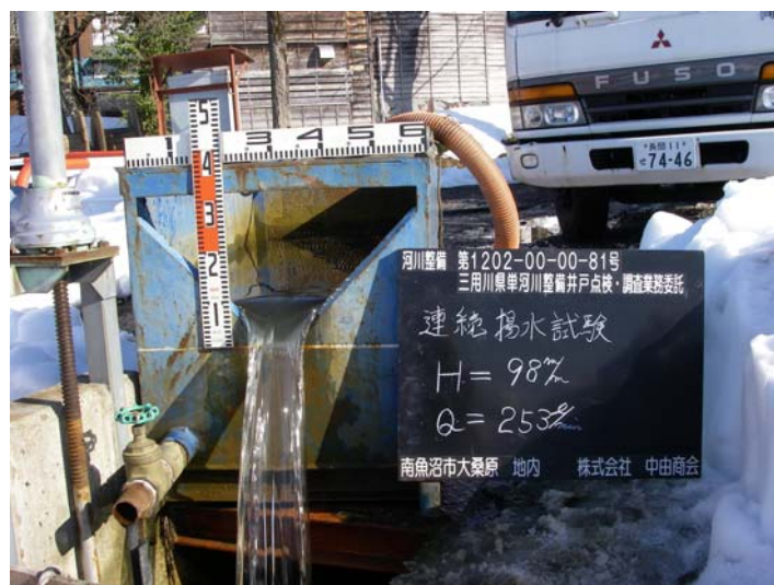
掘削完了後揚水試験
